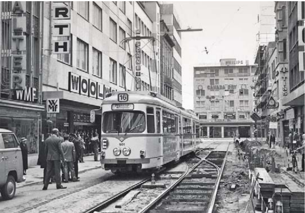
Gleisbauarbeiten in der Frankfurter Straße, 1969. Auf seiner Fahrt nach Frankfurt passiert ein „O“-Wagen die Baustelle. [3]
